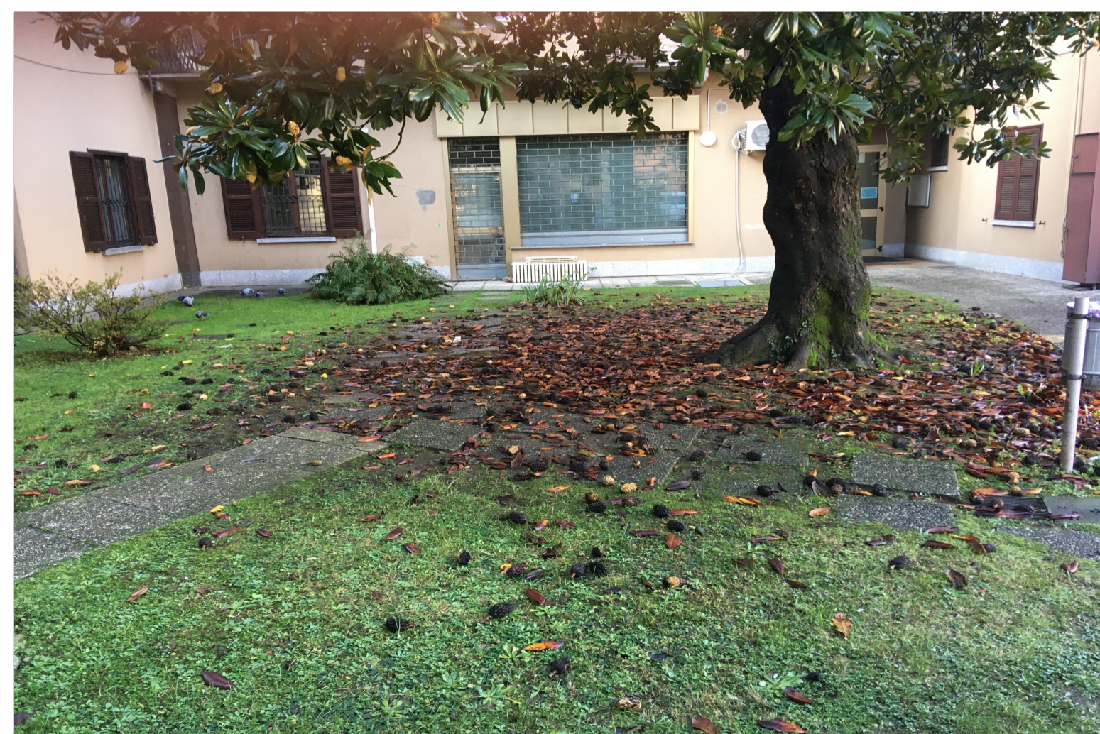
FOTO 3 - PANORAMICA LATI NORD ED EST DA VIA G. DI VITTORIO
