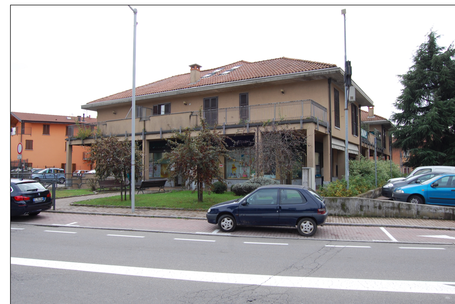
FOTO 2 - PANORAMICA LATO NORD DA VIA G. DI VITTORIO
